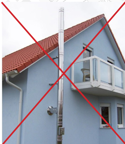
Außenschornsteine an der Straßenfassade
