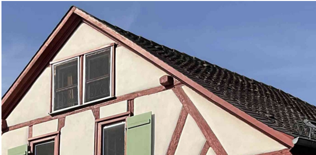
Schmale Ausgestaltung des Ortgangs
