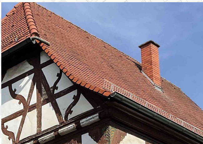
Rote Biberschwanzziegel auf Krüppelwalmdach
