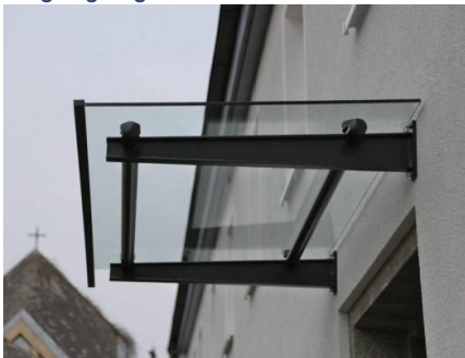
Schlichte Vordachkonstruktion
