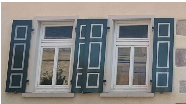
Fenster mit symmetrischer Teilung und Klappläden
