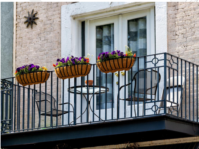
Schlichte Geländerkonstruktion an einem Balkon
