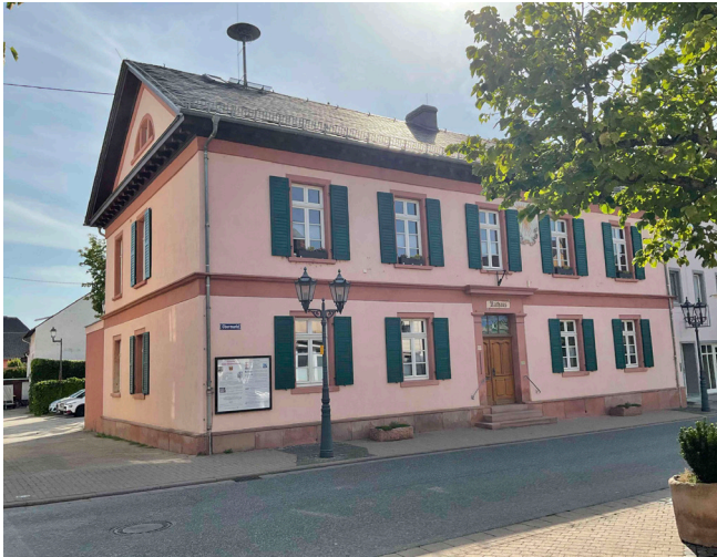
Geschossgesimse und Putzfassade sowie akzentuierenden Klappläden am Rathaus
