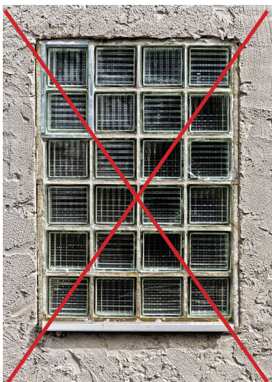
Glasbausteine sollen zurückgebaut werden
