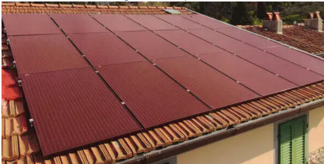
Solarpaneele in farblicher Angleichung an Dacheindeckung
