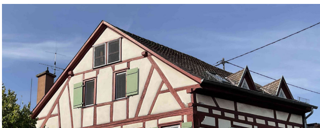
Satteldach mit Belichtung über Dachgauben
