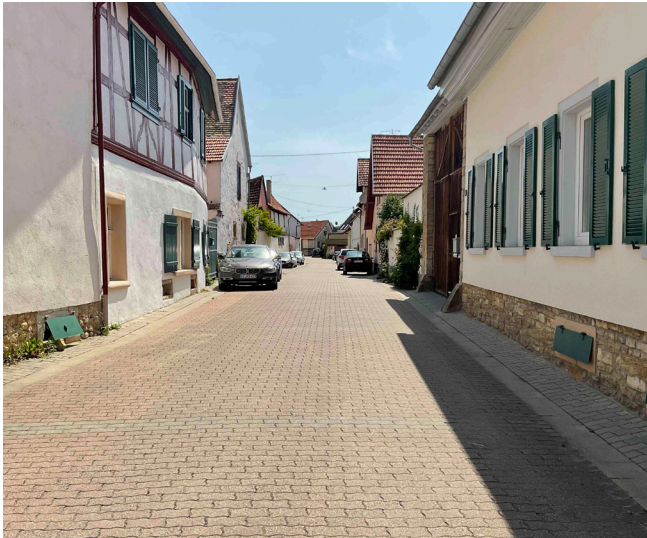
Helle Putzfassade und ausgebildeter Natursteinsockel
