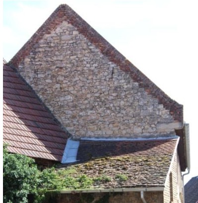
Abbildung: Falz- und Biberschwanzziegeldeckung
