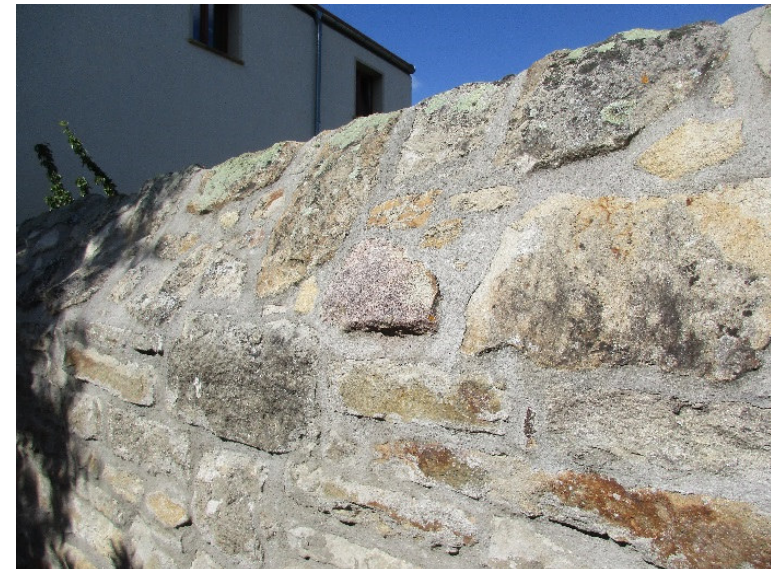
Beispielhafte Natursteinmauer in Bornheim
