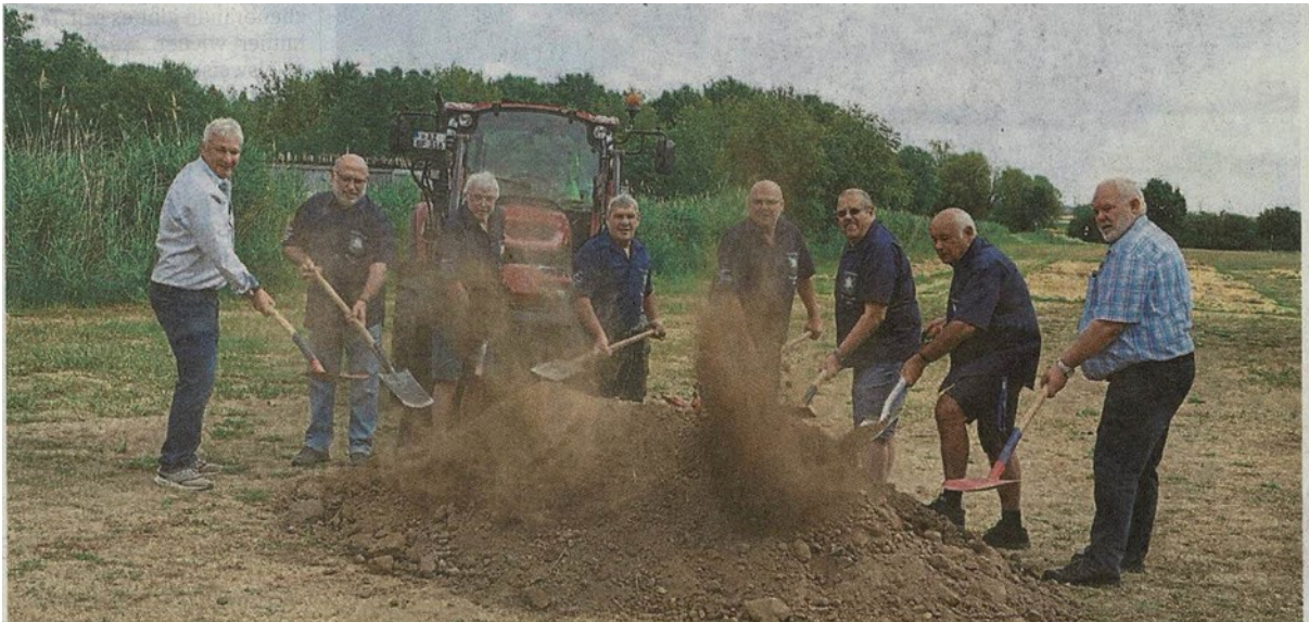
Am ersten Spatenstich zum Bau des Mehrgenerationenplatzes beteiligten sich (v.l.) Bernhard Menges, Arno Wanninger, Erich Eller, Michael Ahl, Klaus Deichmann, Ernst Kissel, Georg Deicher und Felix Schmidt. Foto: pakalski-press/Boris Korpak
